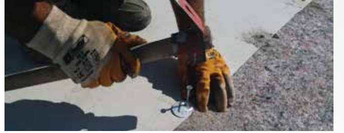
Tpo Membran Uygulaması
