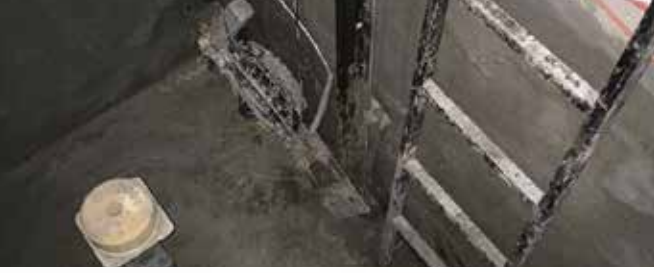
Reimco - Asansör Kuyusu Su Yalıtımı Uygulaması
