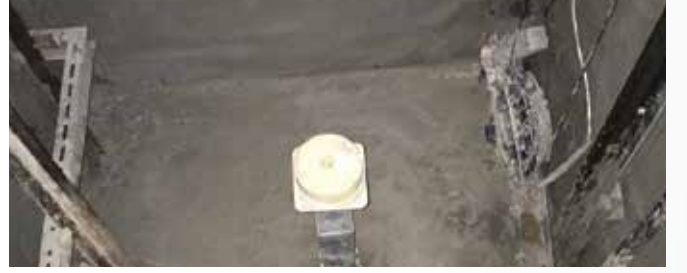
Reimco - Asansör Kuyusu Su Yalıtımı Uygulaması
