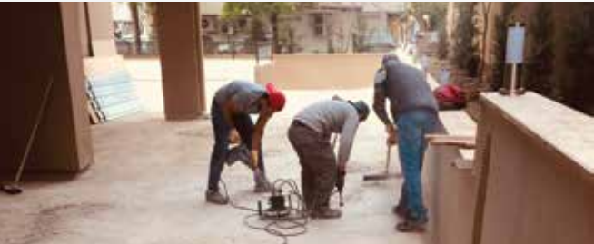
Sadıkoğlu İnşaat - Otopark Üstü Su Yalıtımı Uygulaması
