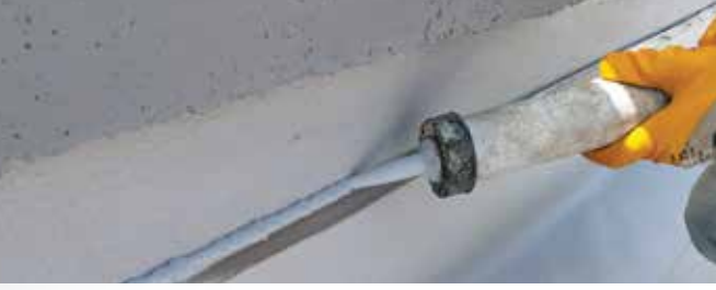
Tpo Membran Uygulaması
