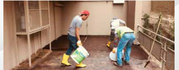
Sadıkoğlu İnşaat - Otopark Üstü Su Yalıtımı Uygulaması
